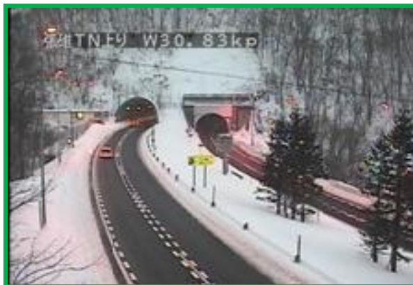
トンネルの先は？
